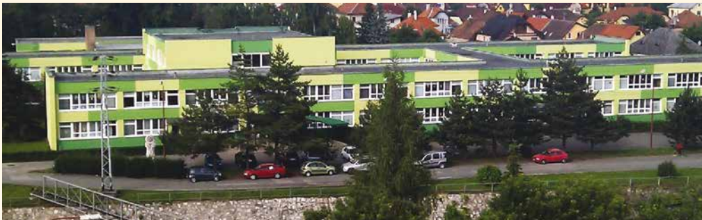
Škola po rekonštrukcii - 2011
