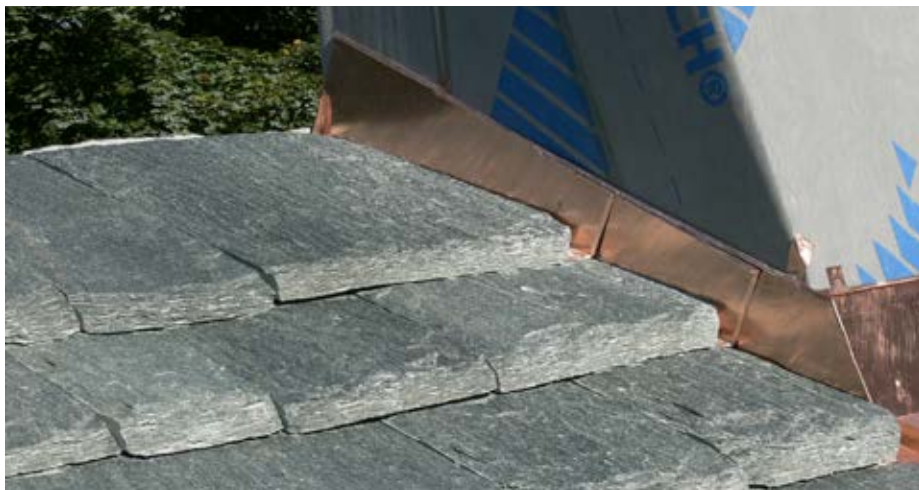
Ukončení u komína, který byl následně také obložen serpentinitem
