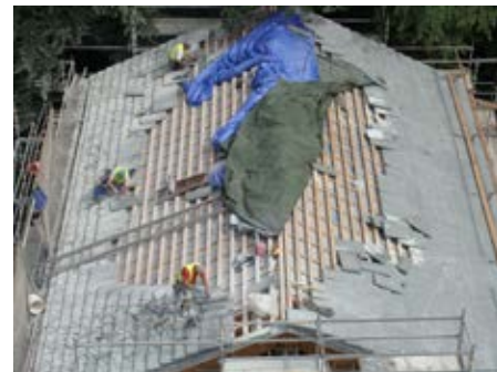
Střechu bylo nutno zatěžovat rovnoměrně ze čtyř stran
