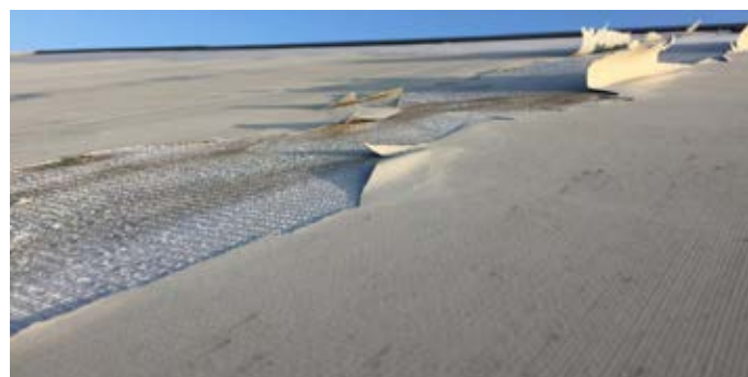
Obr. 4 UV degradovaná mPVC povlaková krytina v štádiu rozpadu (foto: M. Kováč)
