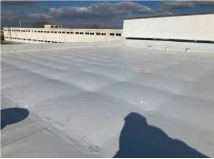
Minimálne namáhanie fólie pri zaťažení silným vetrom.
