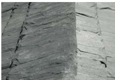
Hřeben je řešen přeložením, protože dodaná tvarovka neměla správný úhel
