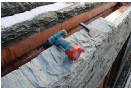
Dokončování obkladu zaatikového žlabu
