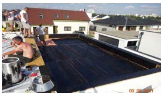
Obr. 6 Ukážka penetrovateľného záklopu pred použitím asfaltovej parozábrany za studena
