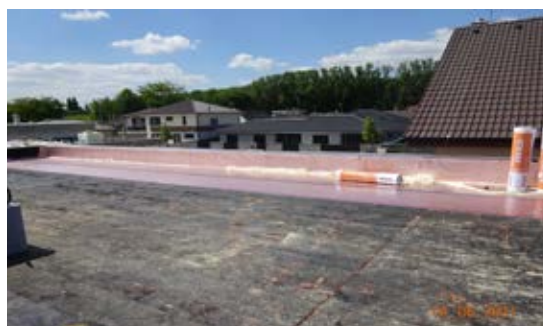
Obr. 7 Ukážka aplikácie asfaltovej parozábrany s hliníkovou fóliou za studena
