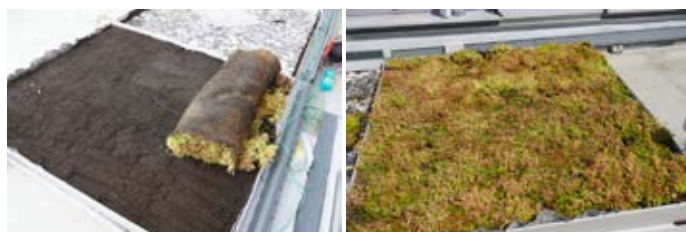
Obr. 3. Zhotovovanie ďalšej skladby v 6/2021: Drenážna a retenčná vrstva, minerálna vlna, zemný substrát a predpestovaný vegetačný koberec.
