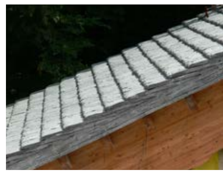
Štítová hrana s vyskládanými kameny
