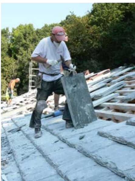
Dvě třetiny kamenů bylo nutno povrchově osekát dlátý, aby kameny správně dosedly
