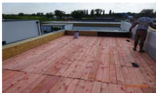
Obr. 5 Ukážka impregnovaného doskového záklopu pre použitie parozábrany
