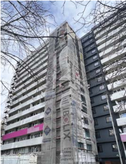
Tysiąclecia 47 – ocieplenie ścian szczytowych budynku
